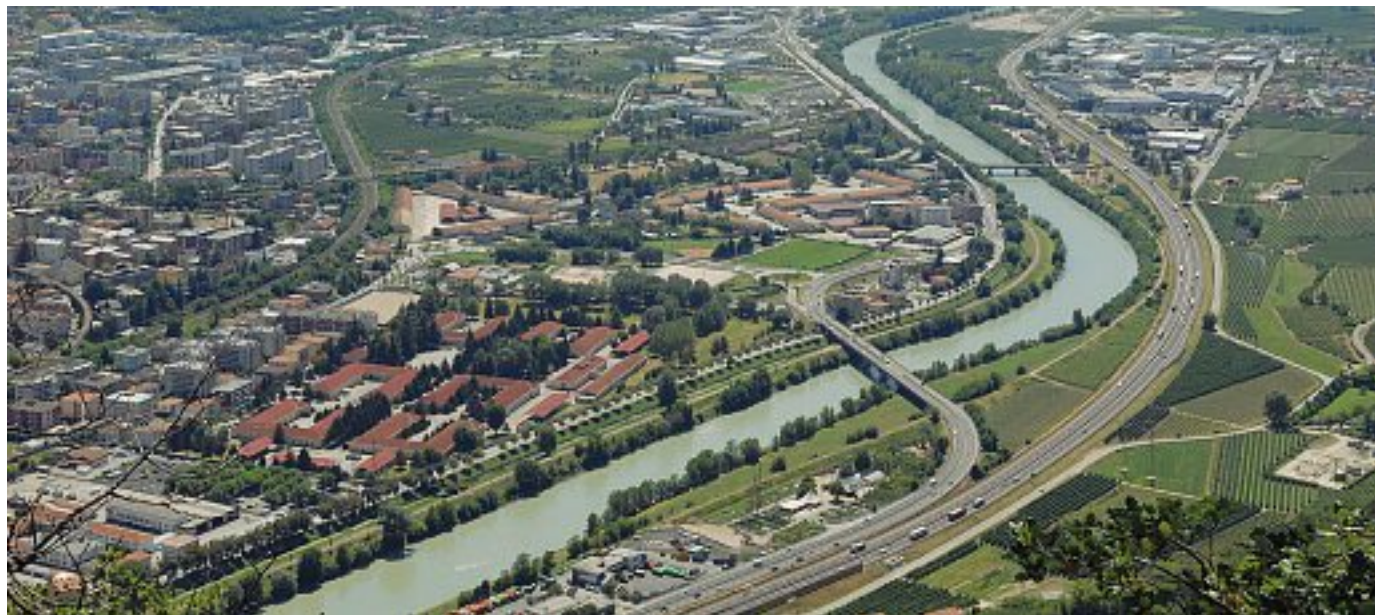
Visioni Il capoluogo trentino nella parte sud: la tangenziale di Trento è uno degli errori tecnologici segnalati da Italia Nostra all'interno del Pup (Rensi)
